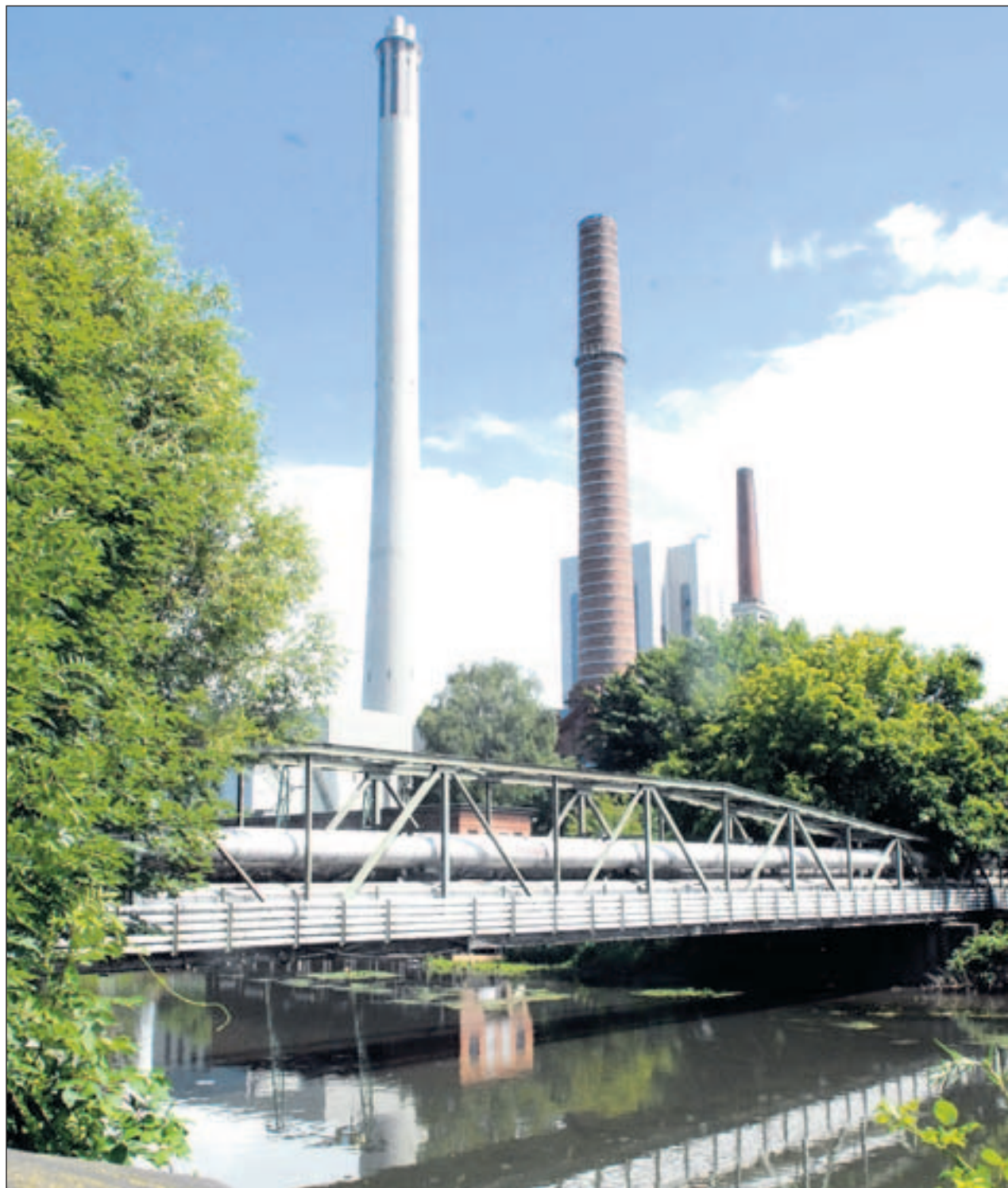
Aus dem Heizkraftwerk Mitte führen gewaltige Fernwärme-Rohre in den Westen der Stadt. Foto: Rudolf Flentje
